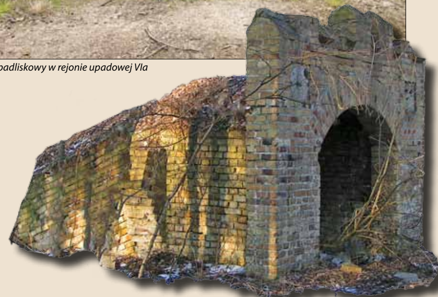
Przykładowy wygląd ceglanej obudowy szybu. Pozostałości upadowej w rejonie na północ od Nowych Czapli
