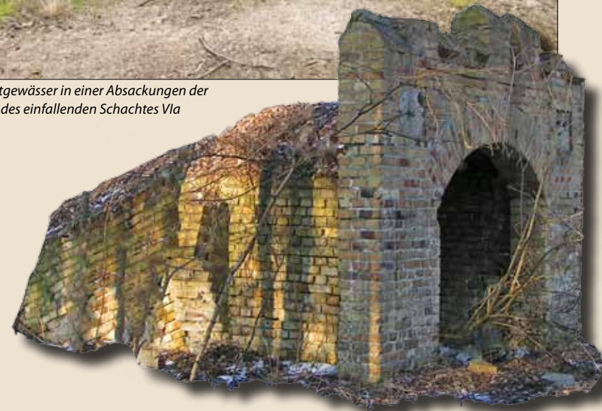
Beispielhaftes Aussehen der Verschalung des Schachtes aus Ziegeln. Der Rest des einfallenden Schachtes nördlich von Nowe Czaple
